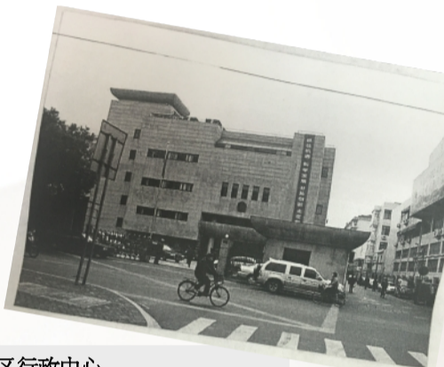
▲杭州市上城区行政中心 位于原后市街16号,1998年荣获“浙江省钱江杯优质工程”奖,那也是杭建工荣获的第一个“钱江杯”。
