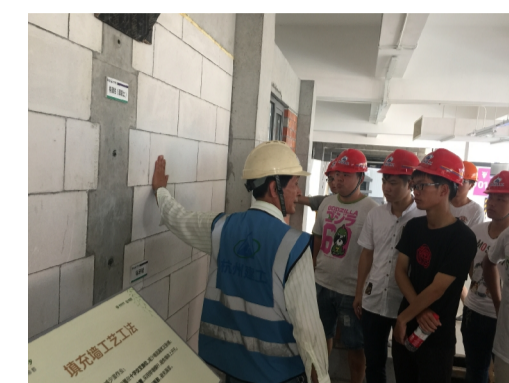
图：新员工观摩集团杨柳郡项目施工现场
